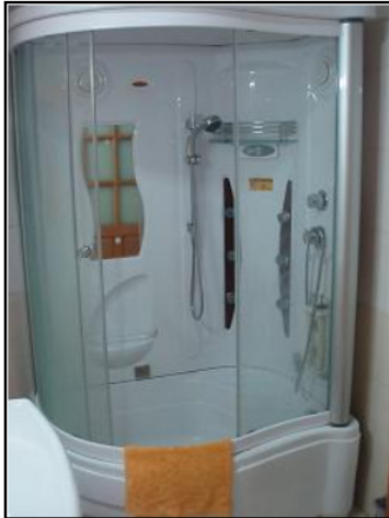
(見た目はいいが10分くらいしてやっと満足できるお湯が出る。しかも、隙間からお湯が漏れてバスルームの床が水浸し。)
